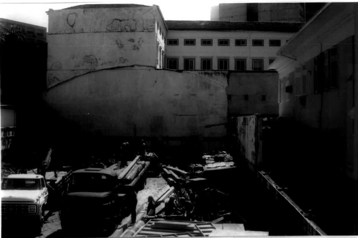
Fotografia 3.3 - Vista da obra Marquês de Olinda com o colégio e a FEMAR.
