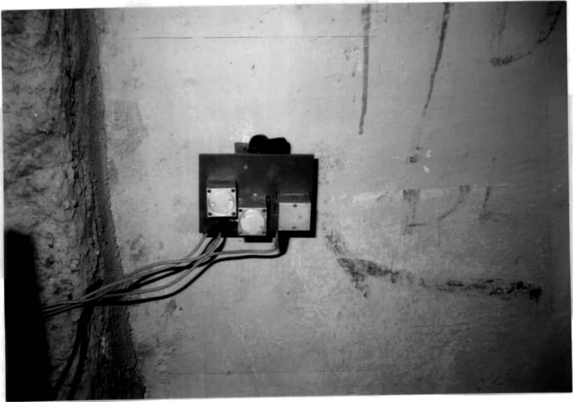
Fotografia 3.1 - Acelerômetros fixados à estrutura
