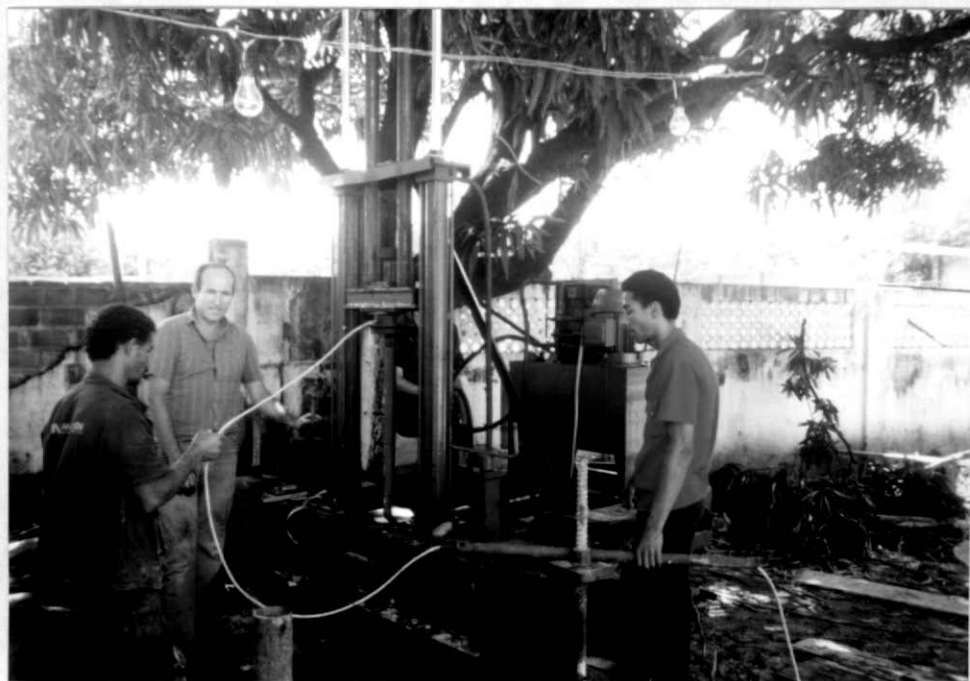
Figura IV.10- Máquina de cravação em operação no campo, durante a realização de um ensaio.
