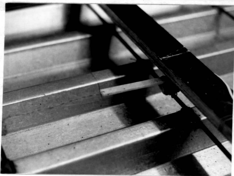
Fig. III.12 - Extensômetro ( E_3 ) embutido no concreto.
