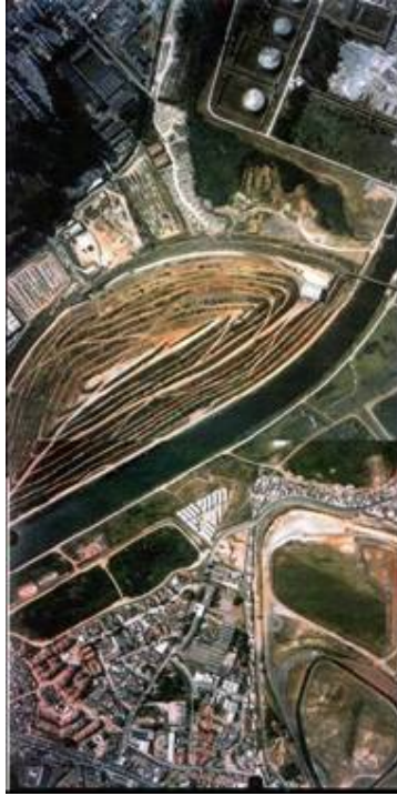
Foto 2 – Vista aérea do Aterro de Santo Amaro (Foto: BASE, 2000 apud PMSP)
