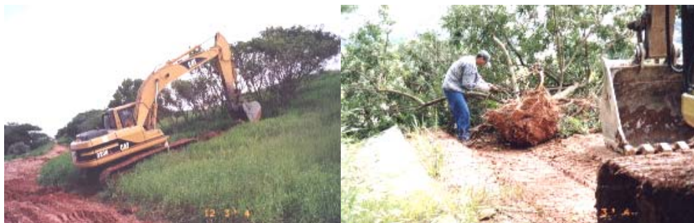
Figura 92 - Abertura de cava e retirada de planta
