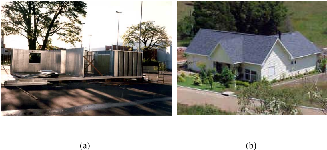
Figura 2.3 Construção residencial baixa em painel diafragma [18]: (a) durante a montagem, (b) residência concluída.
